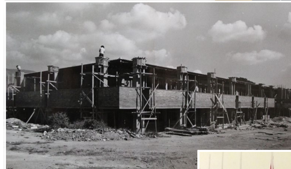
Edificio 2 en construcción, campus 1.
